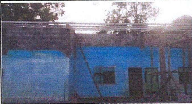
Foto 1: Se observa el proceso el trabajo de las costaneras en donde van las laminas troqueladas de las aulas.
