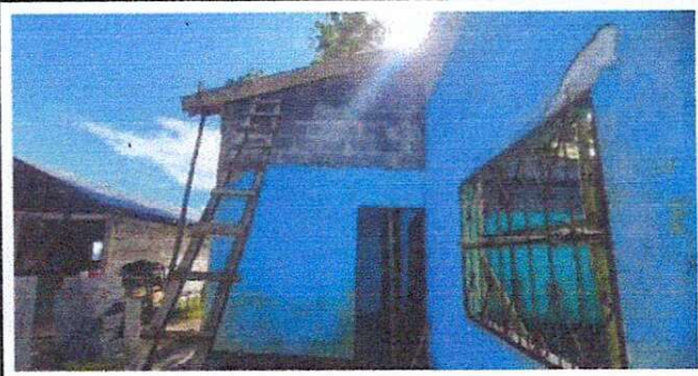
Foto 4: Se observa la puerta en proceso de terminar
