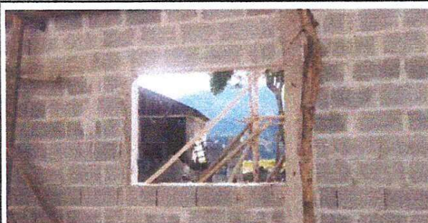
Foto 5: Se Observa el Balcon en proceso de instalacion
